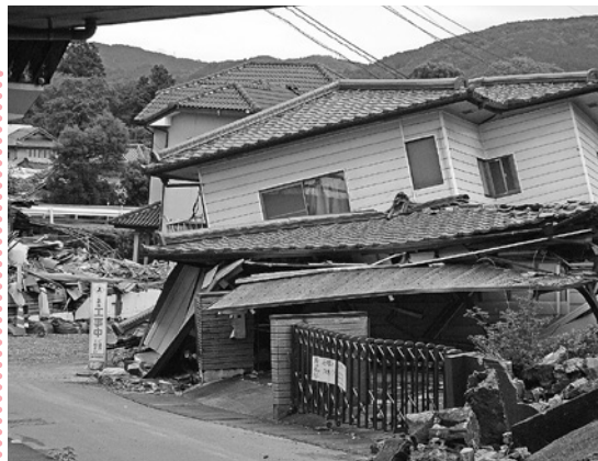
熊本地震被害状況
